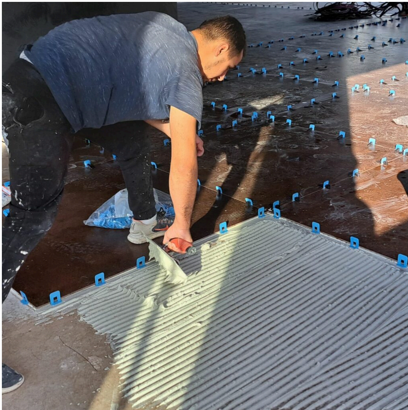
Pose du carrelage ©AB/L'Echo du Mardi
