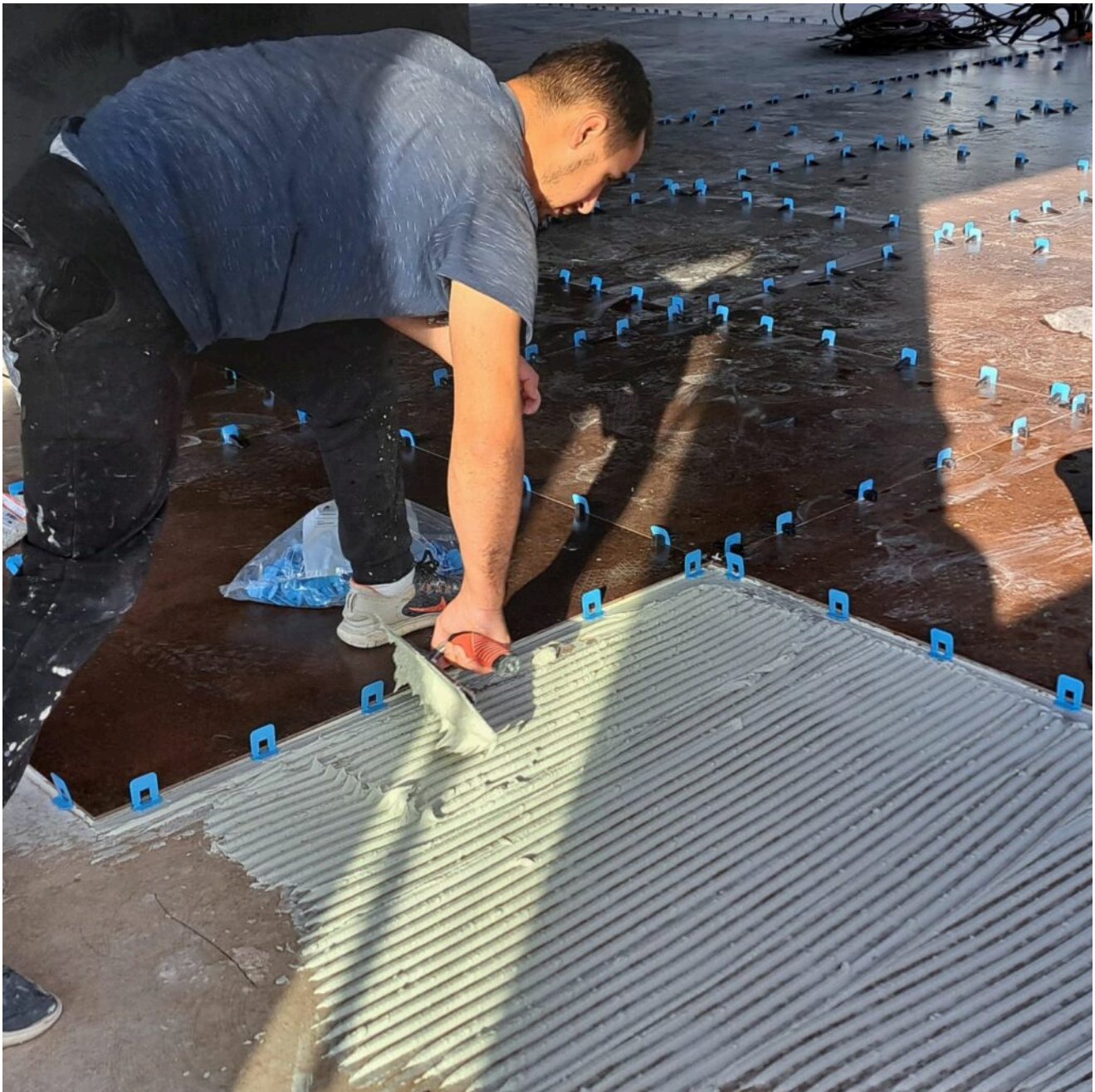
Pose du carrelage ©AB/L'Echo du Mardi
