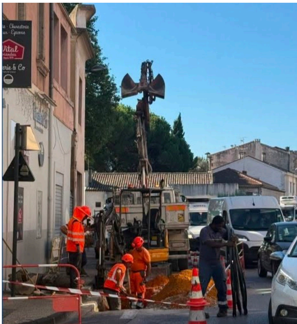
Les techniciens en intervention à Cavaillon ce mercredi 19 août. ©Enedis
