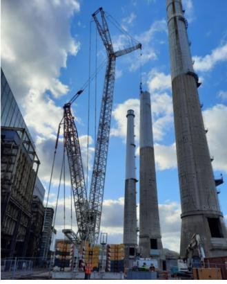
Après le <u>semi-échec de déconstruction</u> par affalement de la cheminée de l'ancienne centrale thermique d'Aramon, la partie inférieure va finalement être grignotée. L'opération devrait débuter d'ici quelques semaines.
