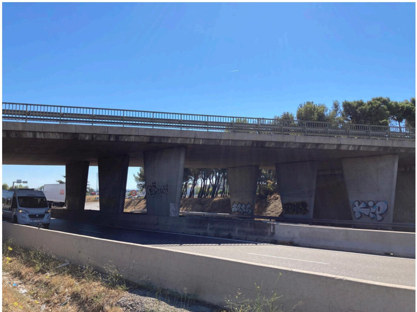
Le pont de la RD907n (route de Sorgues), situé au Pontet, qui permet le franchissement de la RD225 (voie rapide Avignon - Carpentras) va faire l'objet de travaux de réparation dès ce lundi 11 mars, à cause d'une fissuration longitudinale importante due à la variation de température dans la dalle et au trafic élevé supporté par l'ouvrage.
