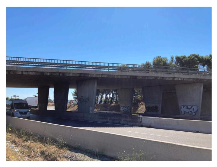
Le pont de la RD907n (route de Sorgues), situé au Pontet, qui permet le franchissement de la RD225 (voie rapide Avignon – Carpentras) va faire l'objet de travaux de réparation dès ce lundi 11 mars, à cause d'une fissuration longitudinale importante due à la variation de température dans la dalle et au trafic élevé supporté par l'ouvrage.
