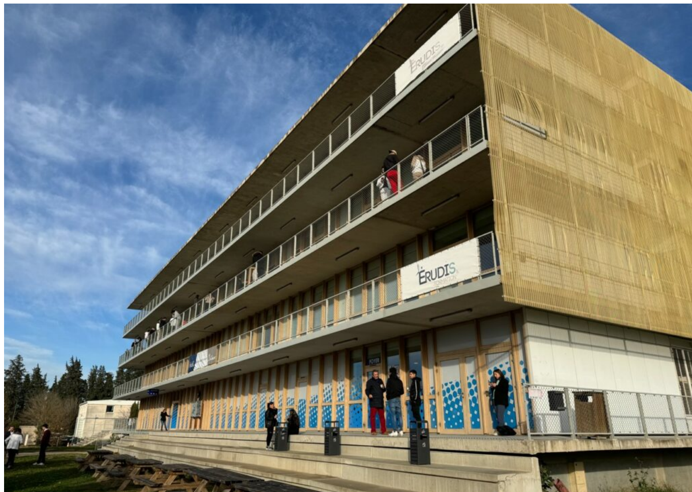
Une partie des locaux actuels situés à Agroparc.
