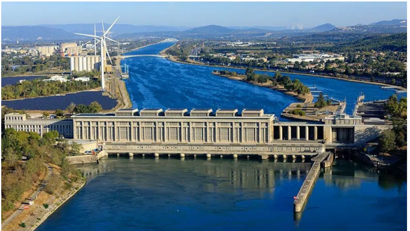
Centrale hydroélectrique de Bollène . ©CNR Bollène
