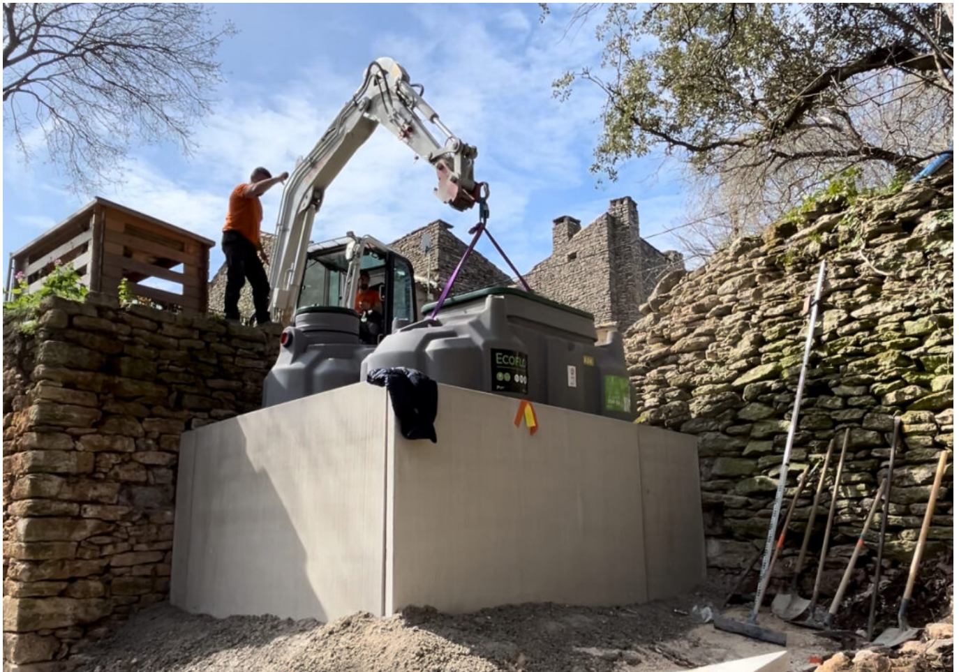
Installation d'une fausse septique Copyright GM terrassement
