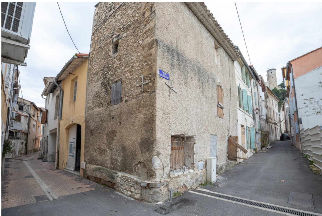
Groupeement d'habitations à Cavaillon avant travaux Copyright Kyaneos
