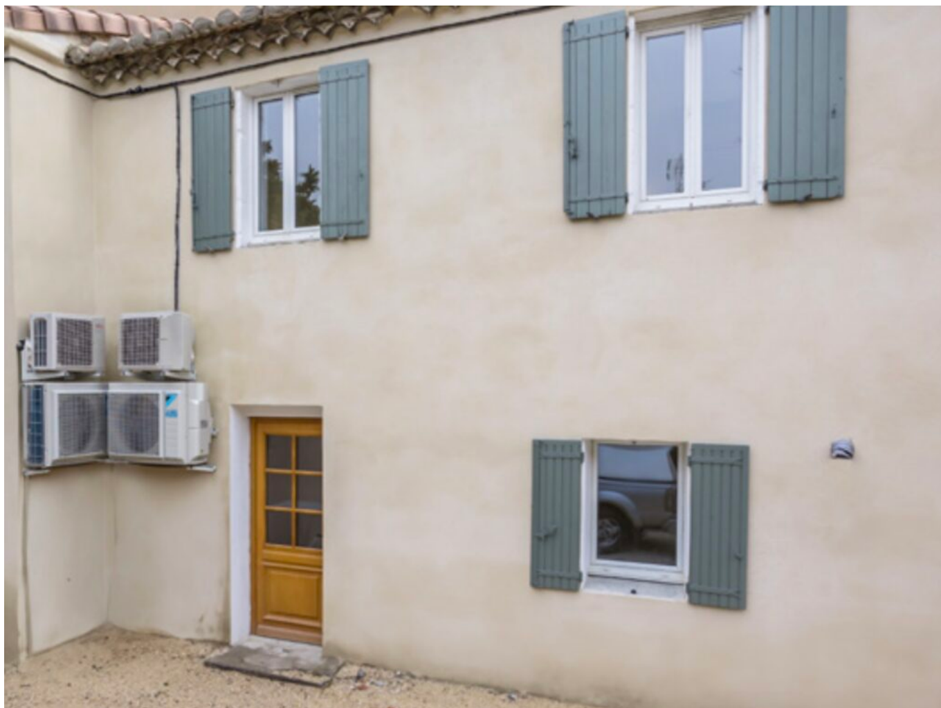
Après travaux à Châteaurenard copyright Kyaneos
