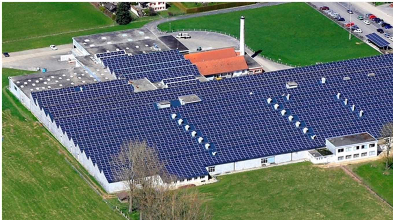
Be Energy Suisse Occidentale DR Be Energy
