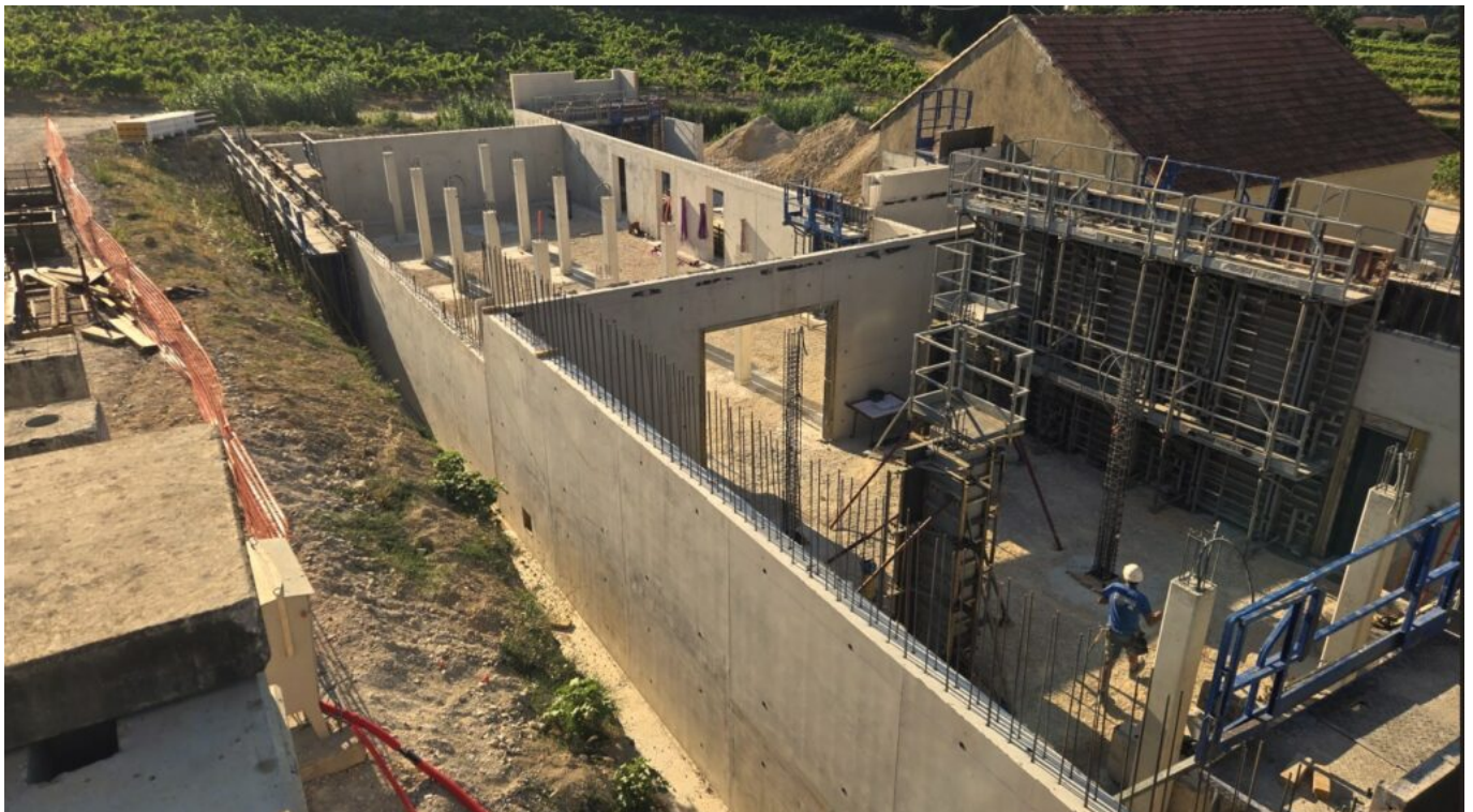
Chantier Batri Diaz à Cairanne Copyright Batri Diaz
