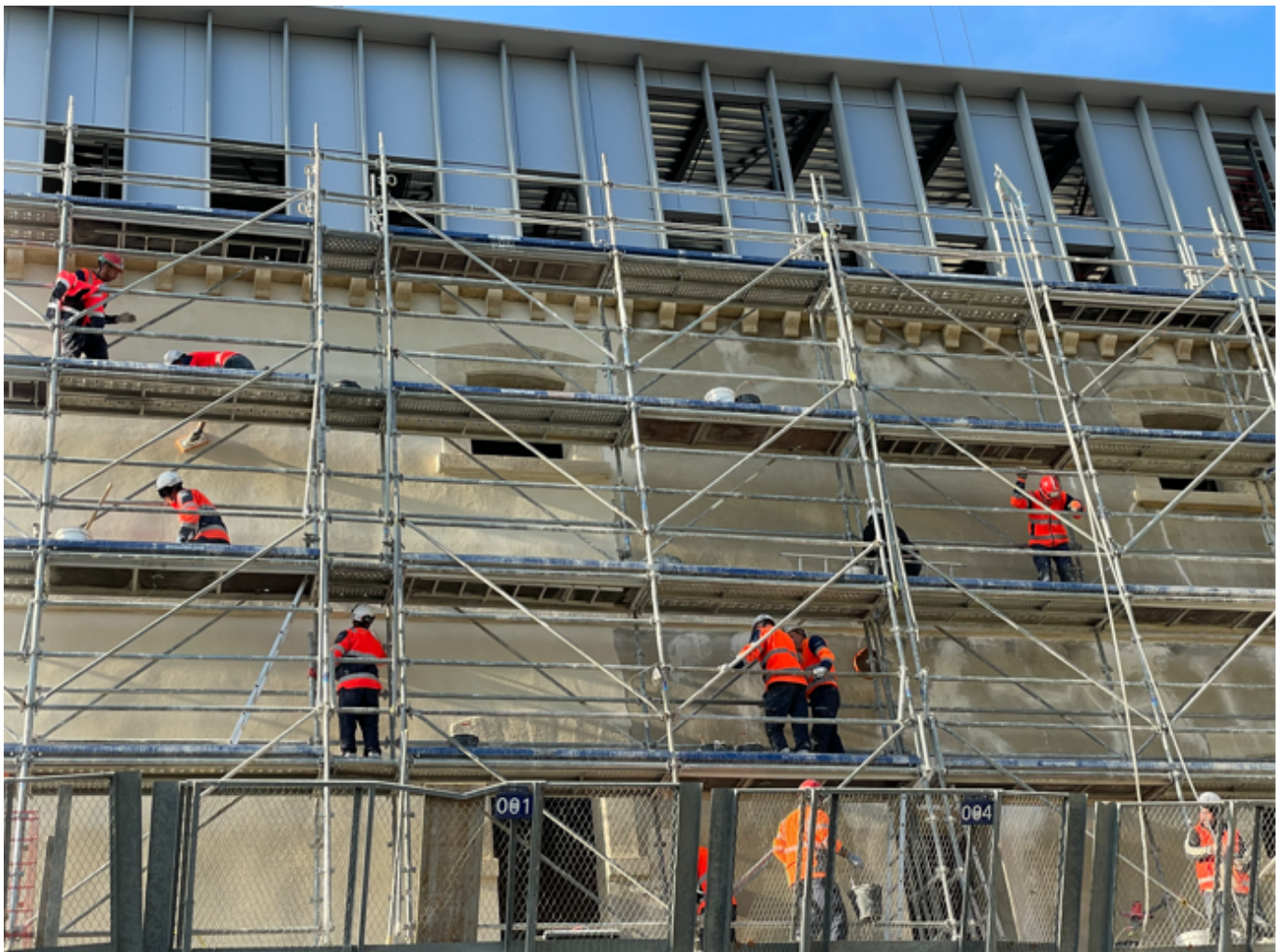
Le badigeon des façades
