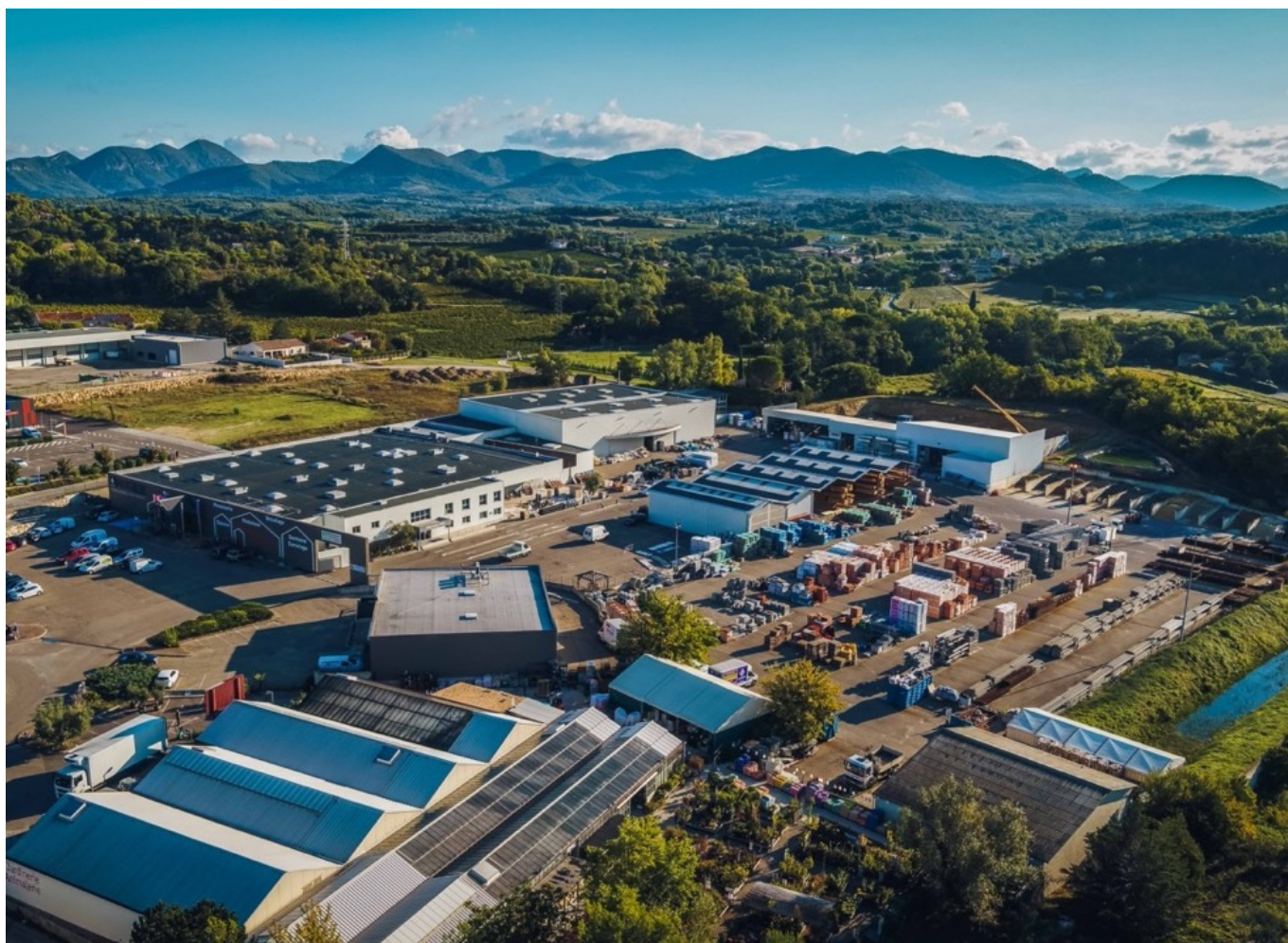
Le site Augier, à Vaison-la-Romaine. ©Augier
