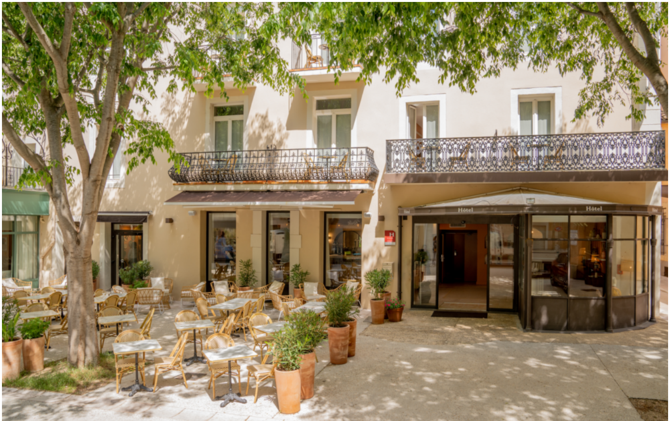
Façade Grand Hôtel d'Orange
