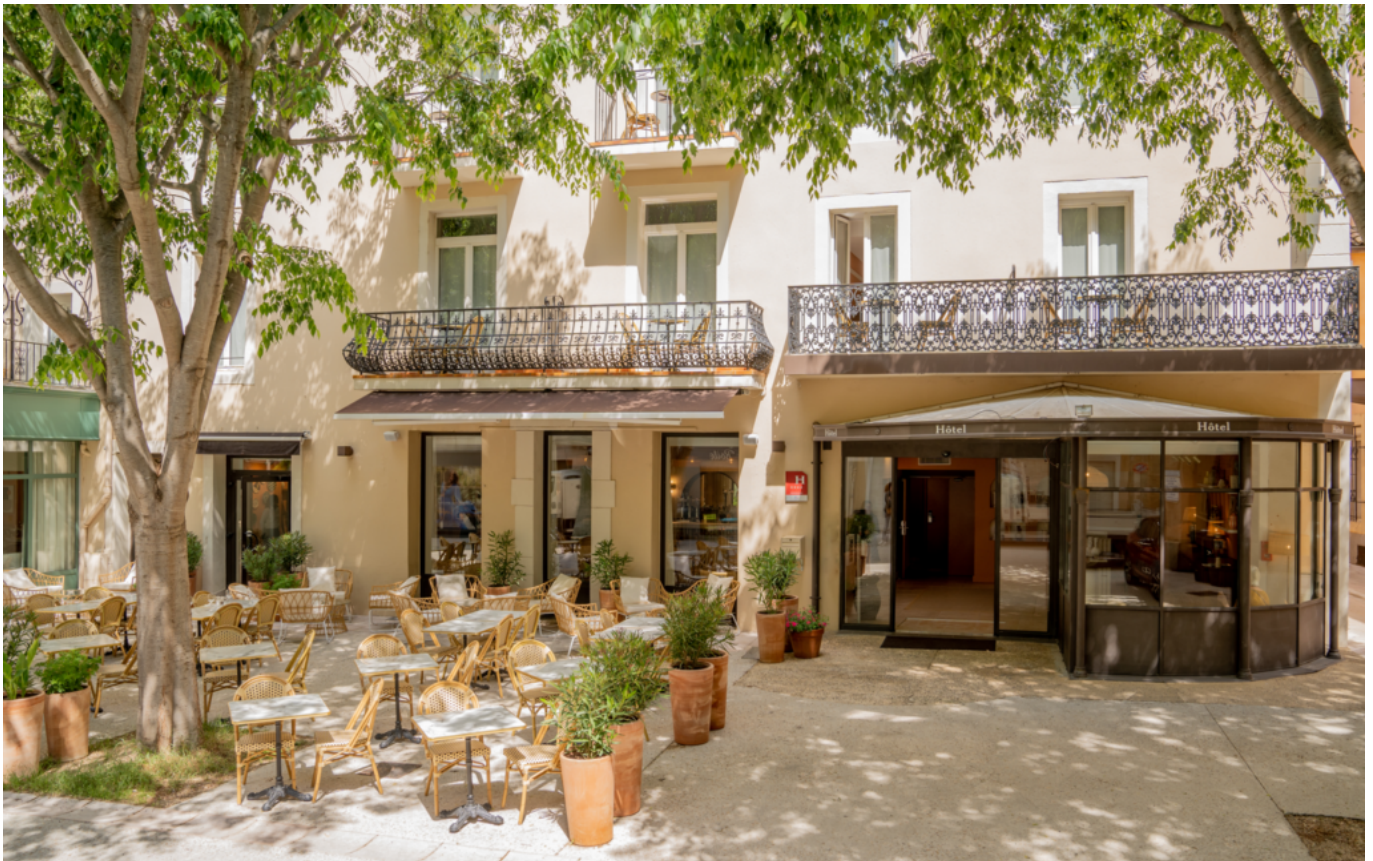
Façade Grand Hôtel d'Orange
