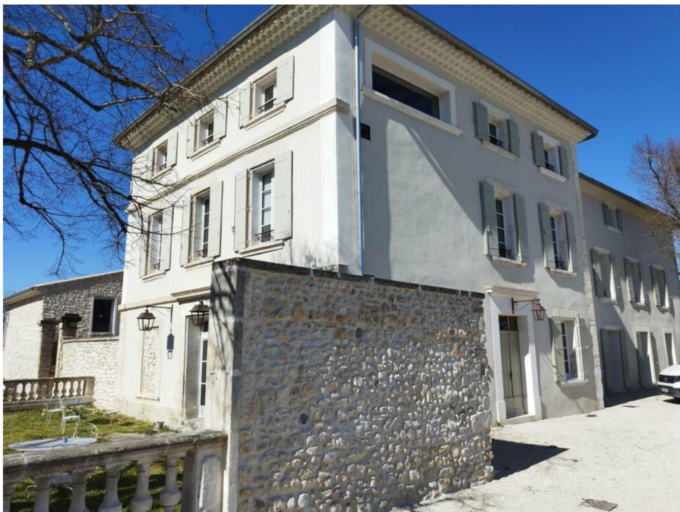
Le siège social situé en pleine campagne a nécessité 3M€ de travaux
