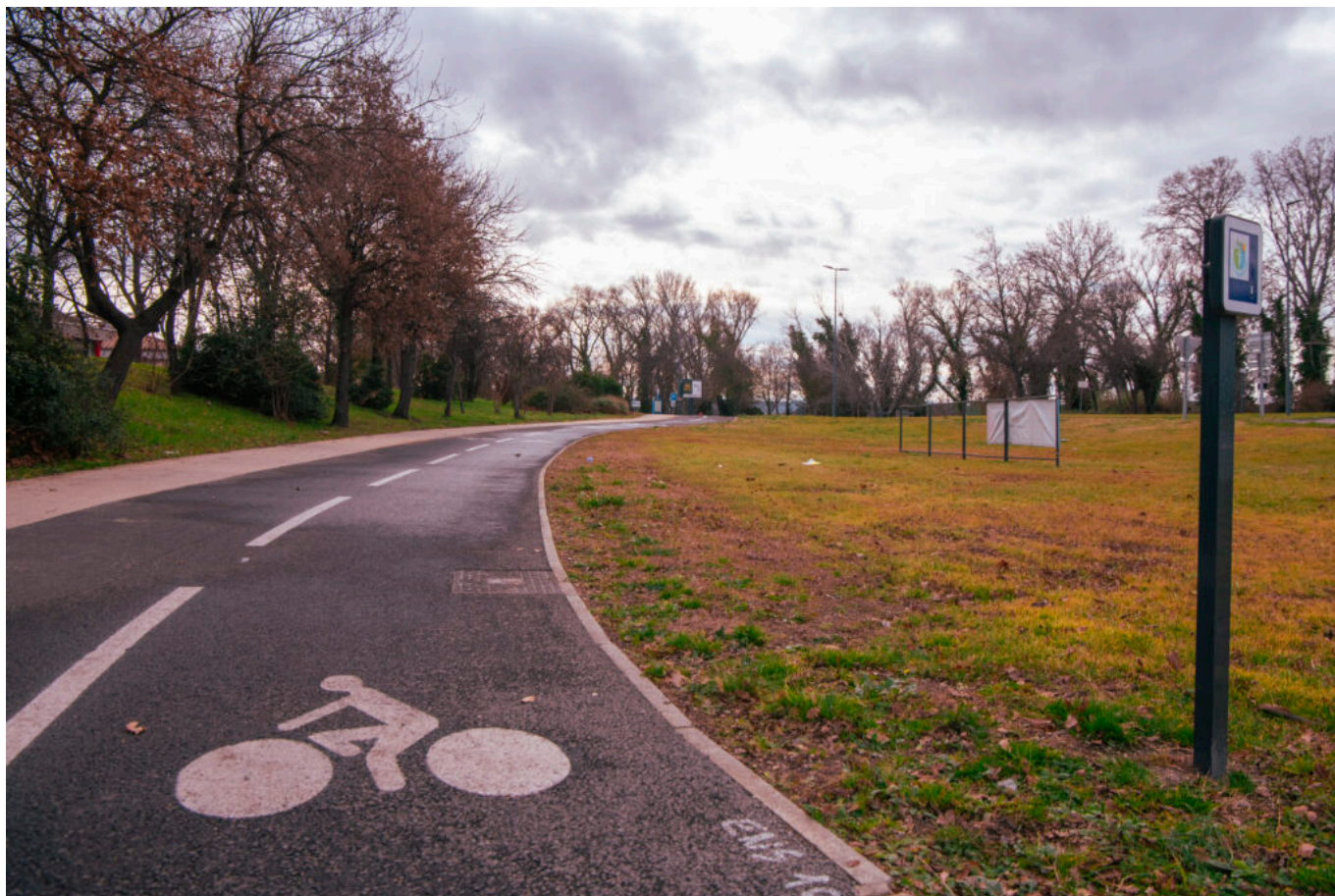
Travaux véloroutes Calavon-Cavaillon Copyright Stéphane Taufer
