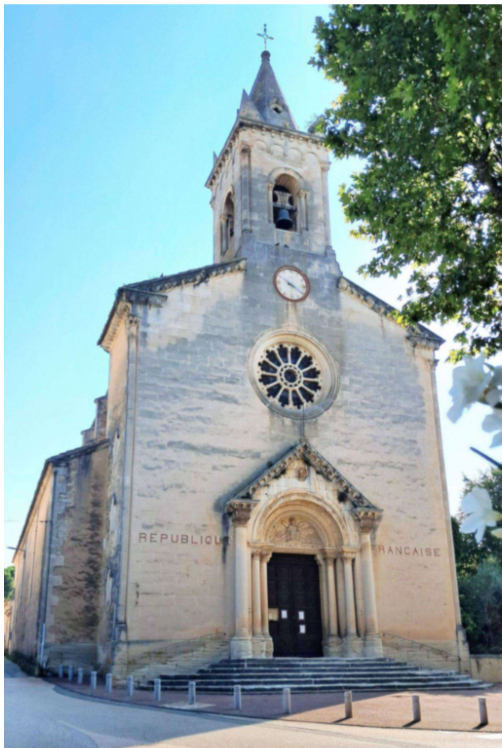
Eglise Saint-André de Villes-sur-Auzon Copyright Villes-sur-Auzon
