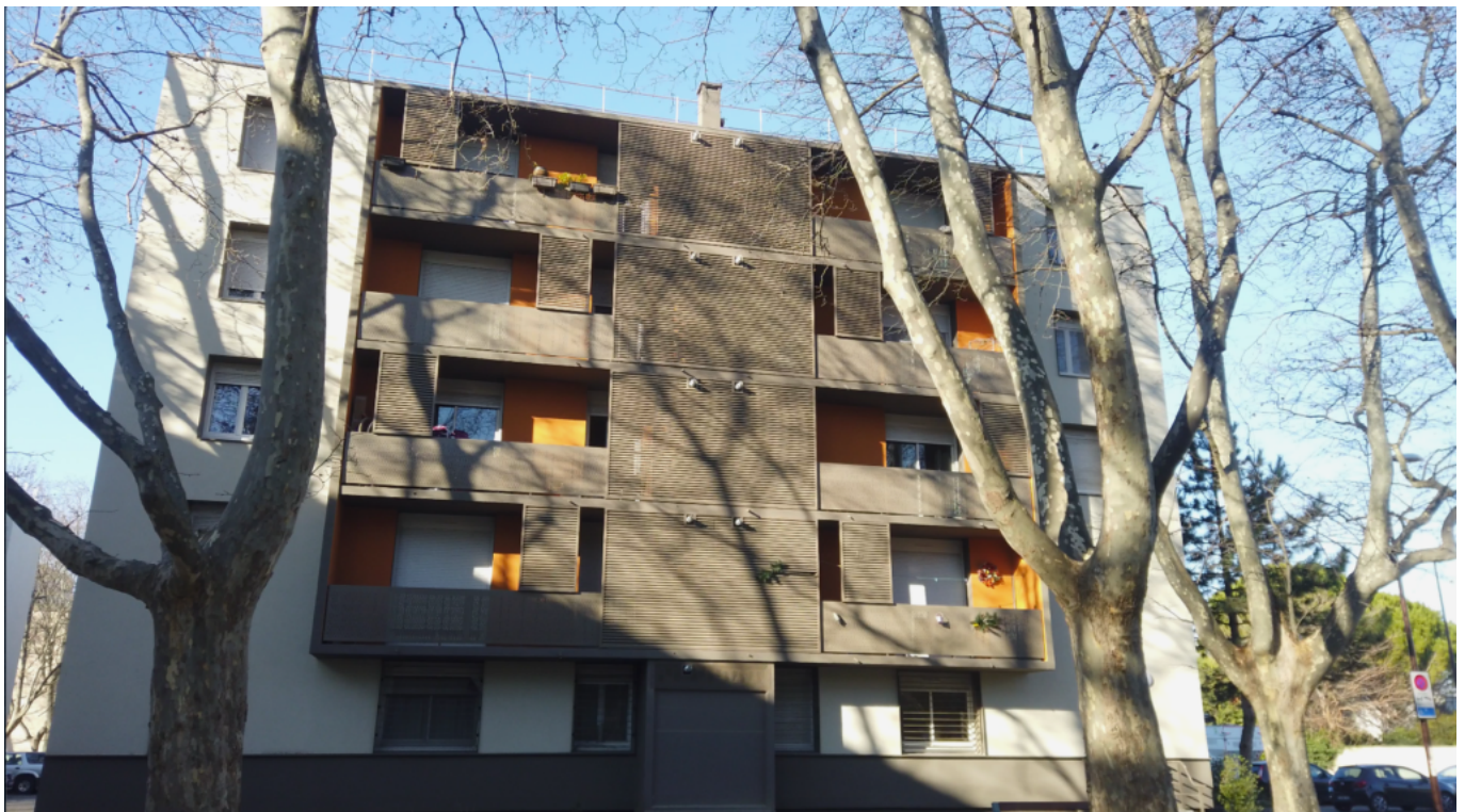
Réhabilitation de Saint-Chamand
