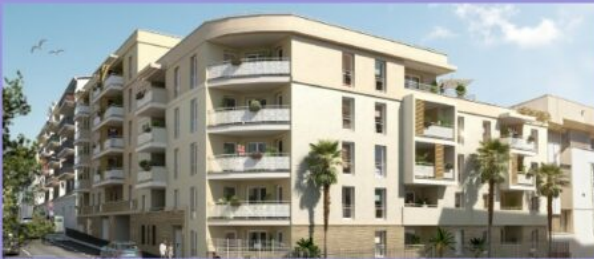
Rosa Nova - Toulon (83) 25 logements // Livraison 2028
