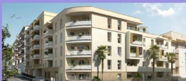
Rosa Nova - Toulon (83) 25 logements // Livraison 2028
