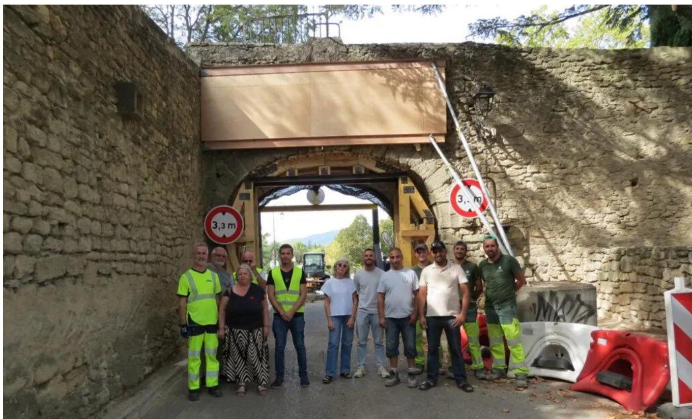
Les équipes de la commune et du département qui ont procédé à la remise en état de l'ouvrage d'art. Crédit : DR/Mairie d'Ansouis
