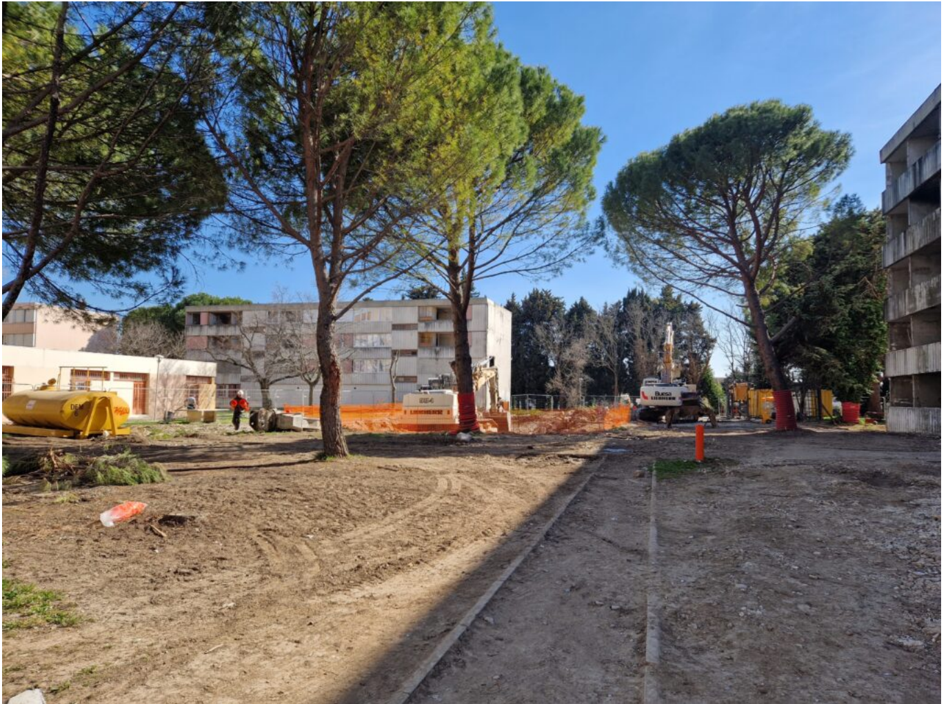
Le chantier en cours
