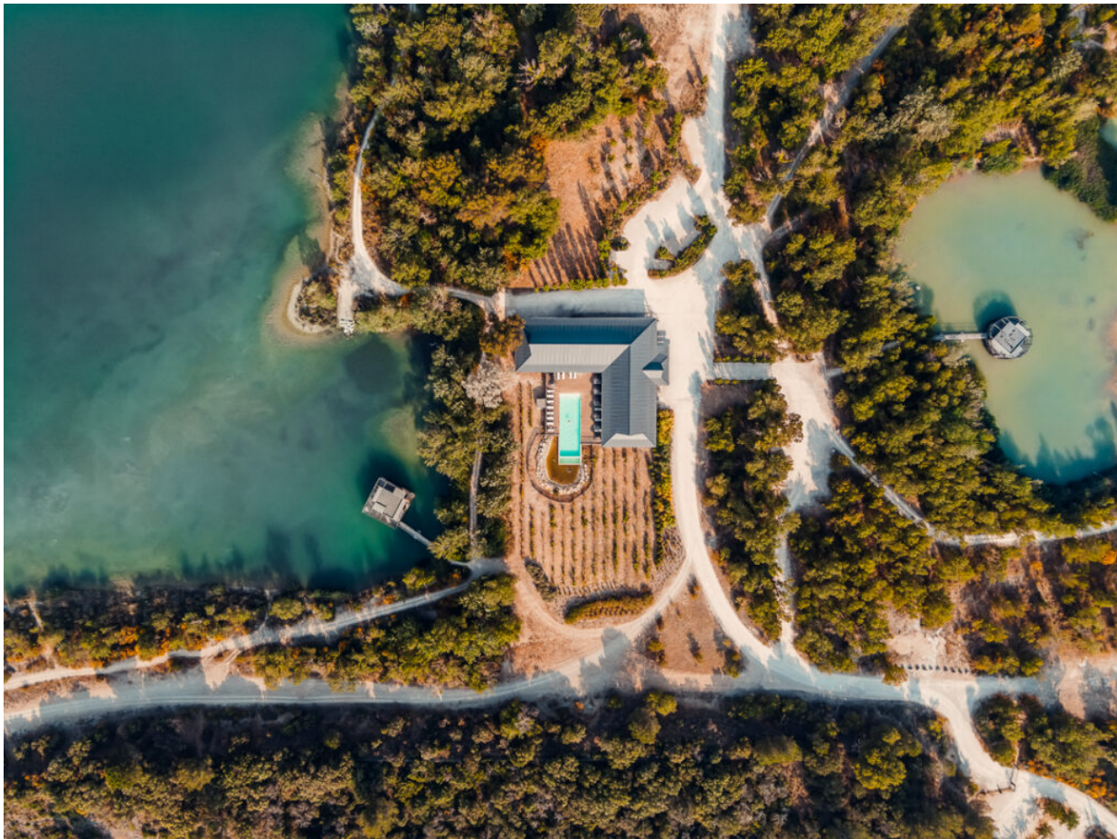
Cabanes des grands cépages à Sorgues
