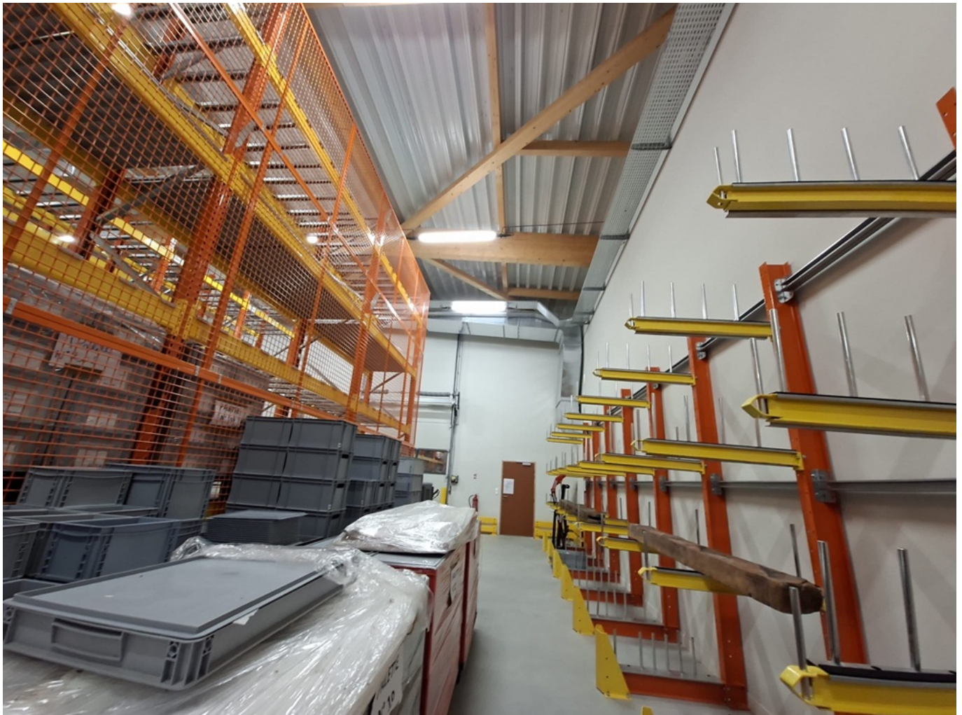
Les galeries de 6m de haut qui abriteront les trésors du patrimoine de Vaucluse
