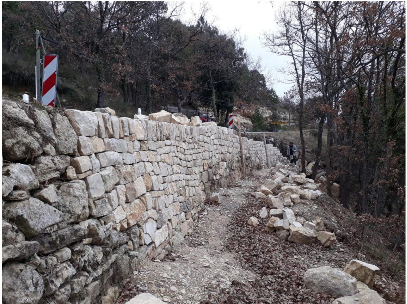
Dans le cadre de sa politique d'entretien des ouvrages d'art routiers, le Conseil départemental de Vaucluse réalise, depuis le 15 juillet et pour une durée prévisionnelle de deux mois, des travaux de réparation d'un mur de soutènement situé sur la RD 48 à Saint- Martin-de-Castillon.
