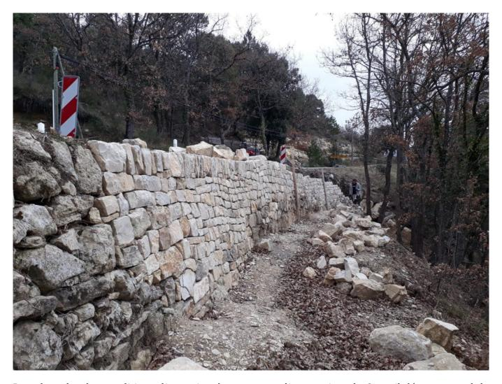
Dans le cadre de sa politique d'entretien des ouvrages d'art routiers, le Conseil départemental de Vaucluse réalise, depuis le 15 juillet et pour une durée prévisionnelle de deux mois, des travaux de réparation d'un mur de soutènement situé sur la RD 48 à Saint-Martin-de-Castillon.
