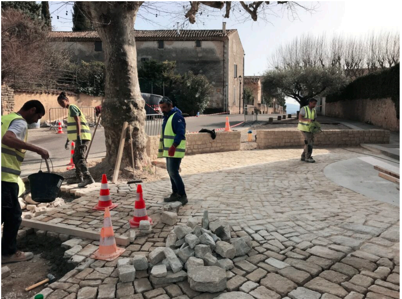
Parvis de l'Église Saint-Pierre de Vassols Copyright La CoVe
