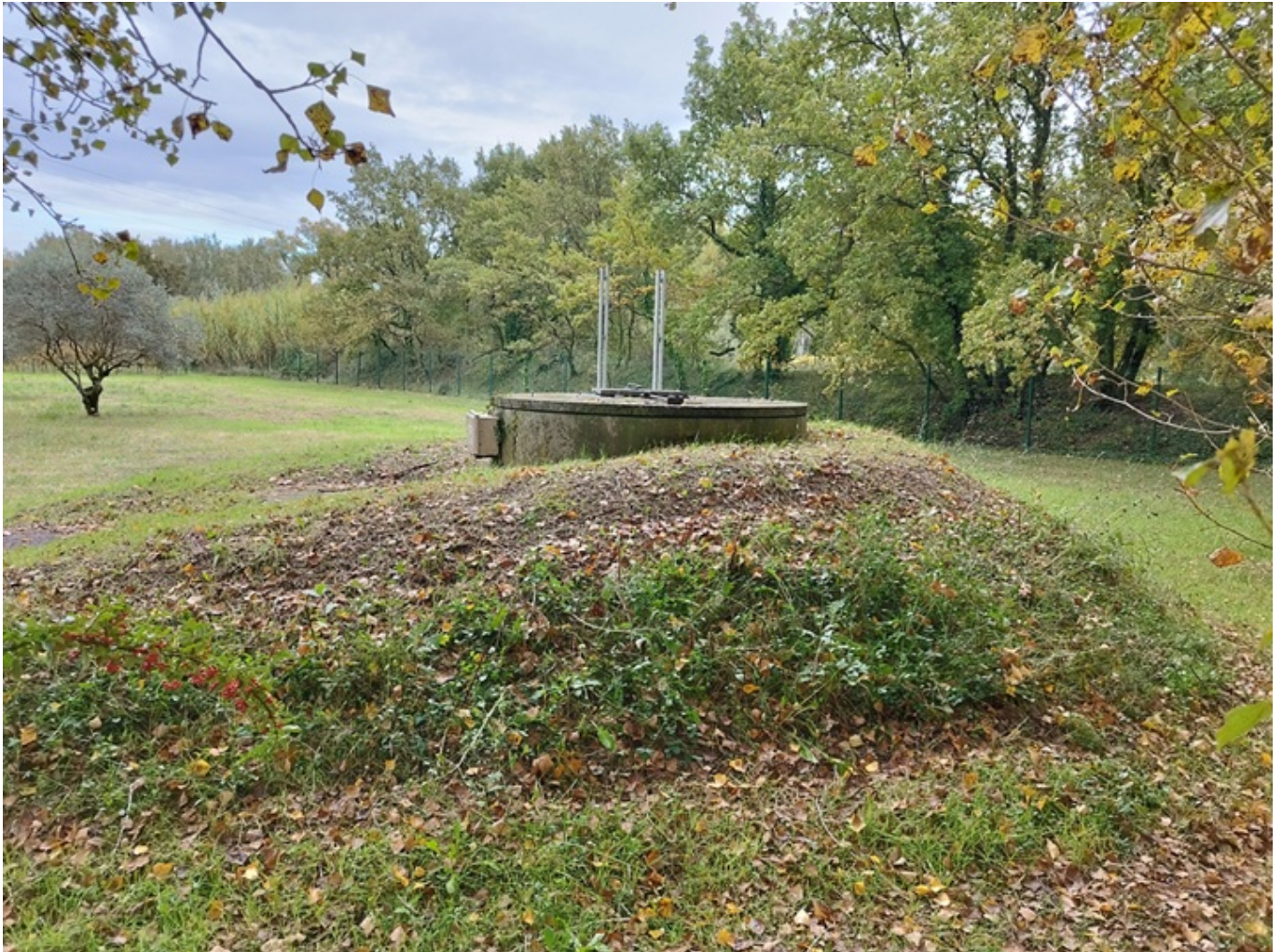
Le point de captage de Grès de Meyras à Aubignan, appartenant au Syndicat Rhône-Ventoux comporte deux forages
