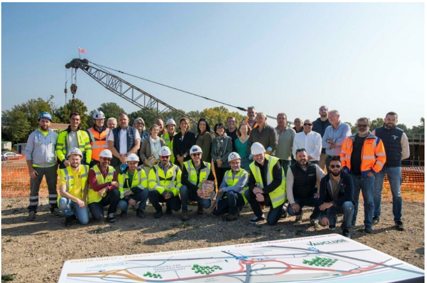
Une visite du chantier a été organisée ce mercredi 14 octobre. ©Département de Vaucluse
