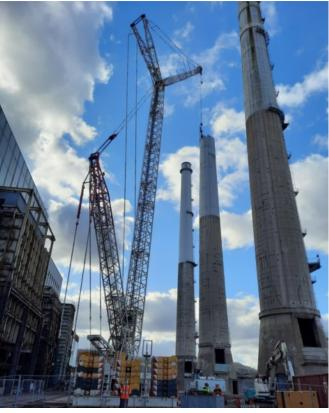
Après le <u>semi-échec de déconstruction</u> par affalement de la cheminée de l'ancienne centrale thermique d'Aramon, la partie inférieure va finalement être grignotée. L'opération devrait débuter d'ici quelques semaines.
