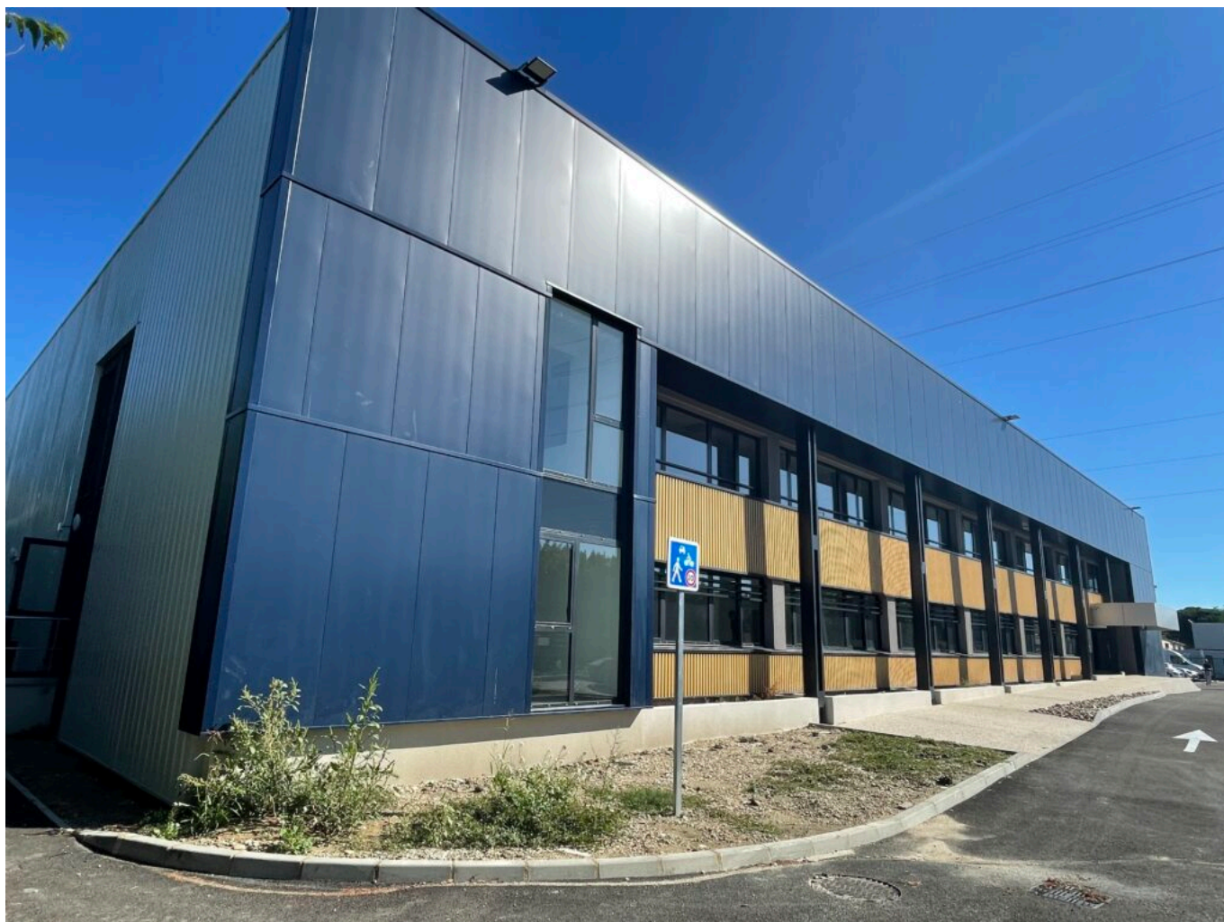
Montéa Bâtiment A, Courtine, Copyright MMH
