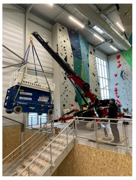
Cette grue 'araignée' électrique rétractable est capable de sortir jusqu'à 5 tonnes de matériel de la fosse,
