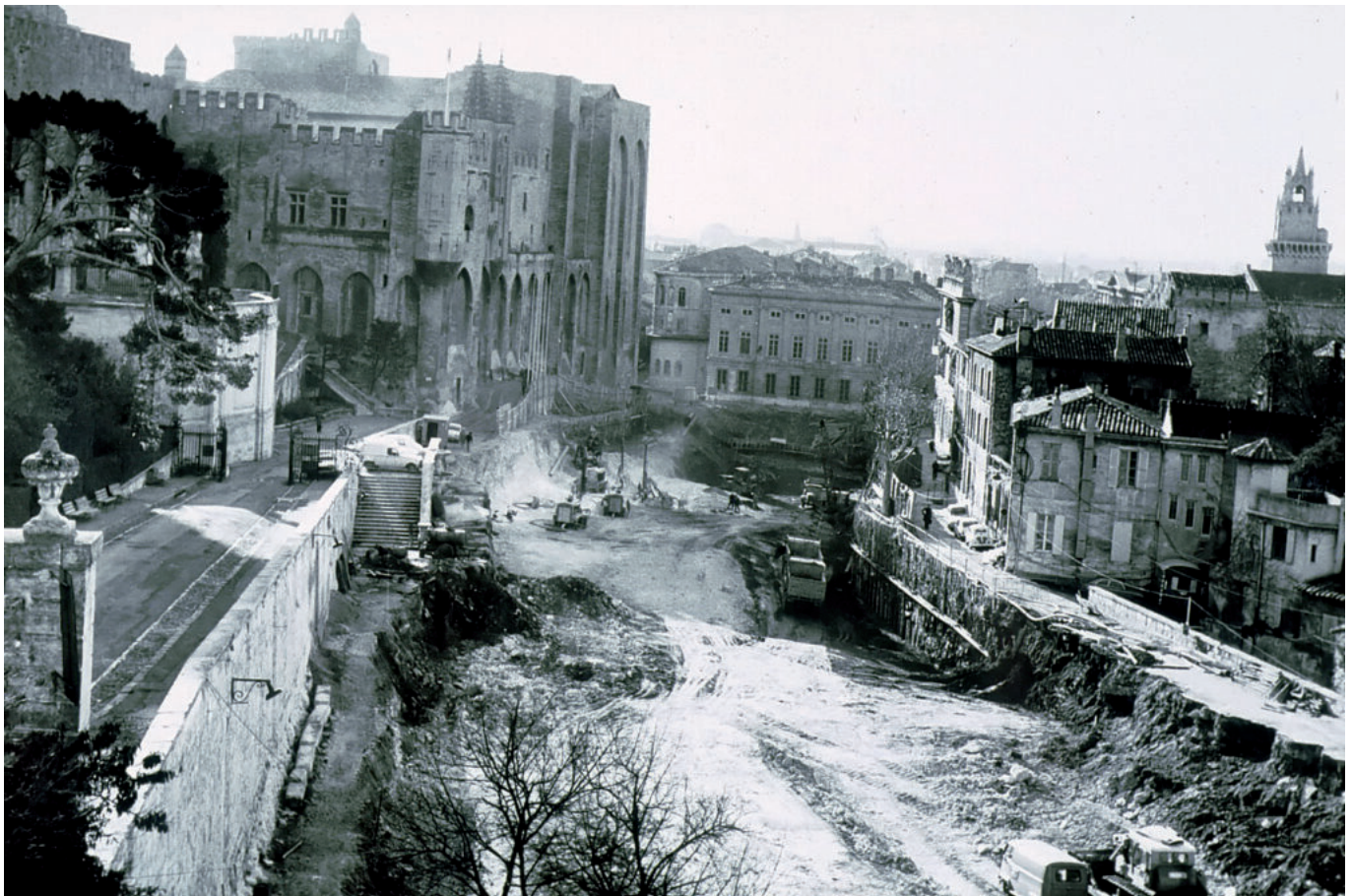
La construction du parking du palais des papes. © DR/Citadis/Archives
