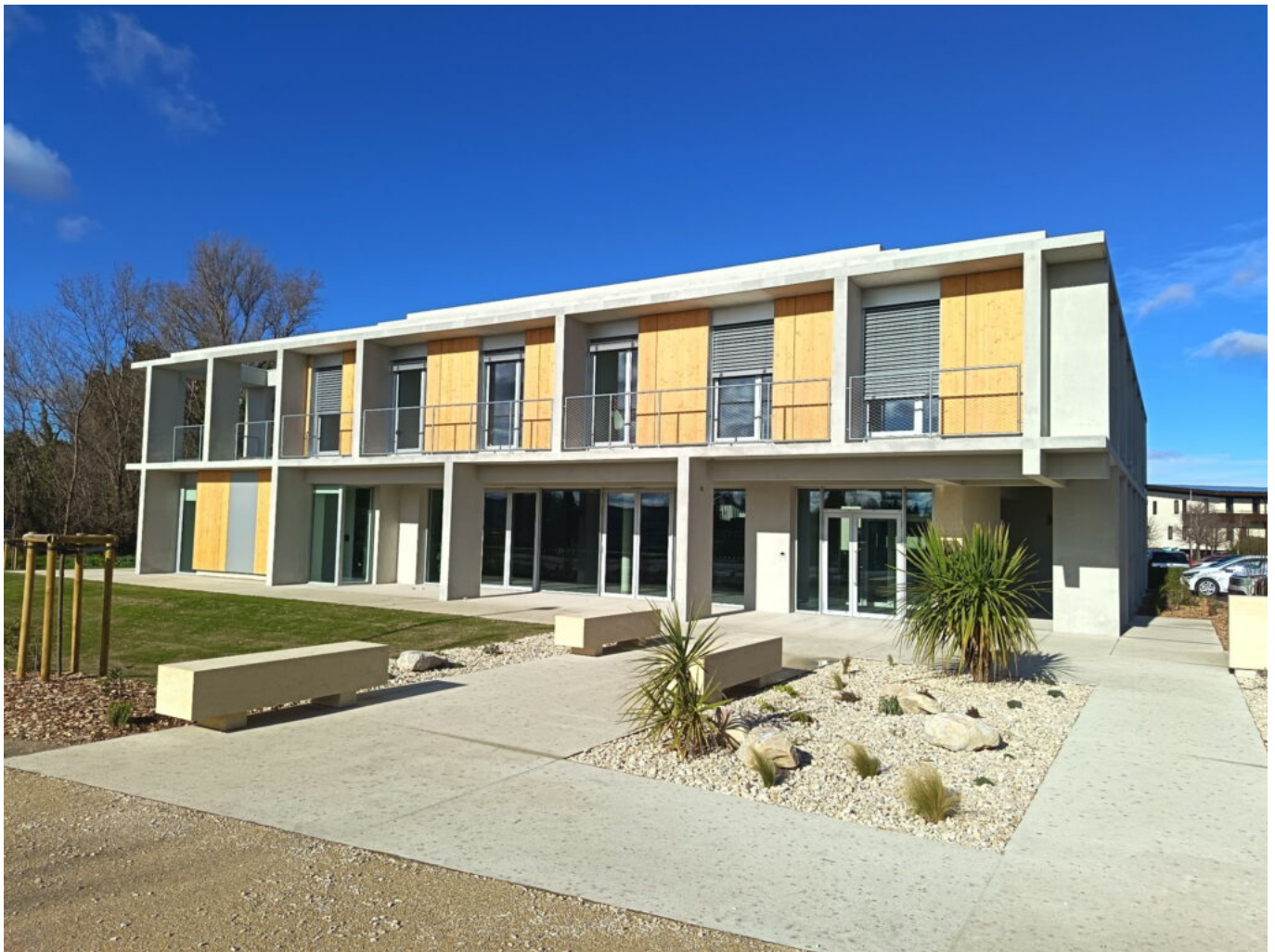
La Maison de la Fédé BTP 84. Copyright Fédé BTP 84
