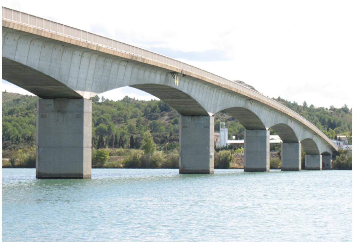
Le conseil départemental du Gard vient de procéder à la réfection de la bande de roulement du pont d'Aramon. L'opération, qui s'est déroulée les 1<sup>er</sup> et 2 juillet derniers, a nécessité la fermeture complète de cette ouvrage à la circulation afin de procéder à la pose des enrobés qui étaient en très mauvais état.
