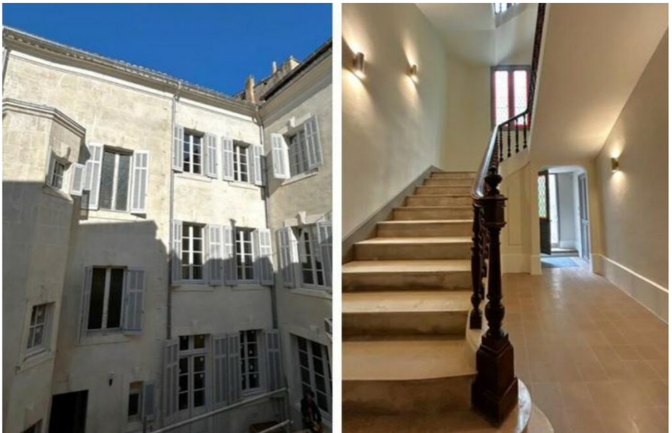
Réhabilitation 6, rue du Roi René à Avignon Copyright Ville d'Avignon
