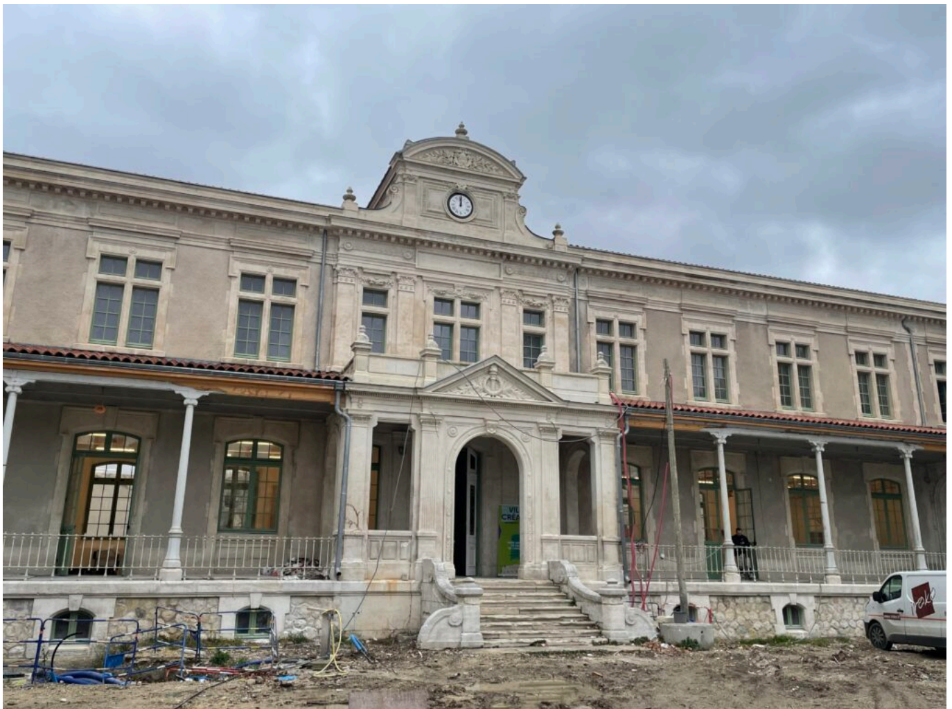
La Villa créative durant sa réhabilitation Copyright MMH
