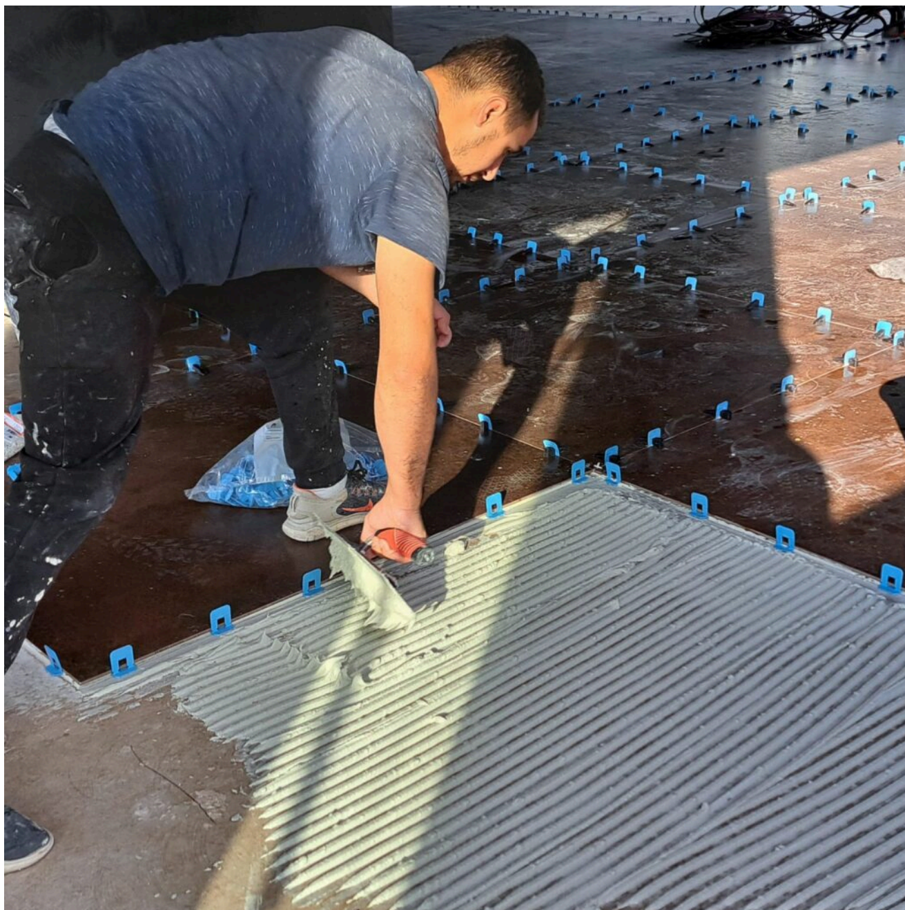
Pose du carrelage ©AB/L'Echo du Mardi
