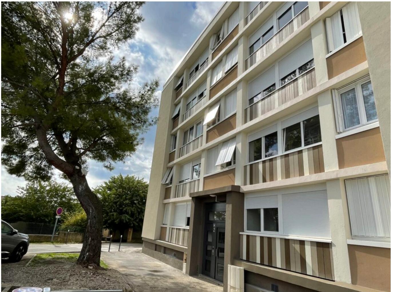
Batiment GDH réhabilité Copyright MMH
