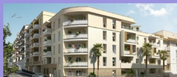
Rosa Nova - Toulon (83) 25 logements // Livraison 2028
