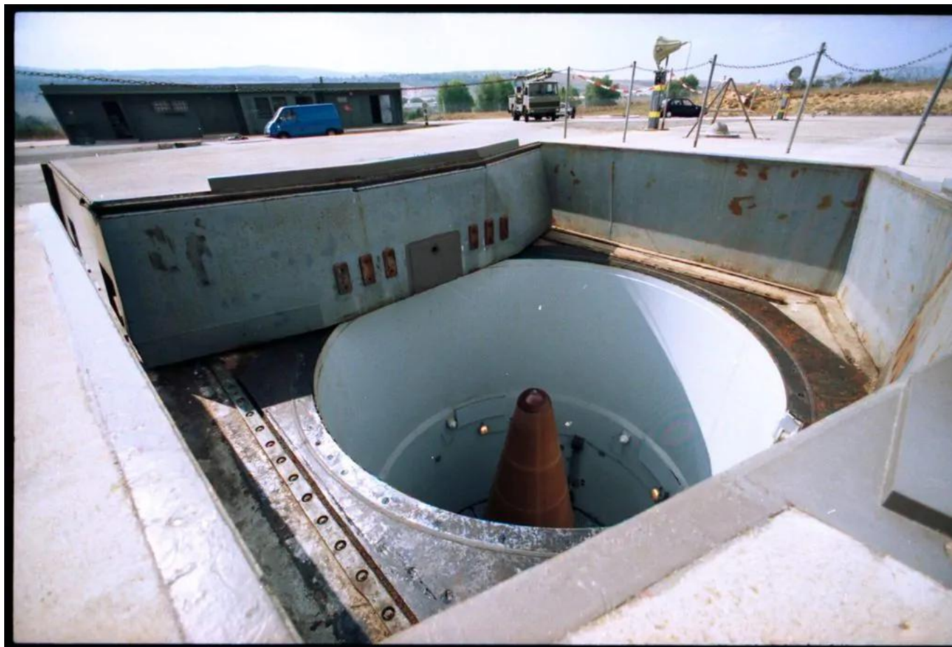
Un missile S3 dans un silo sur la zone de lancement 1
