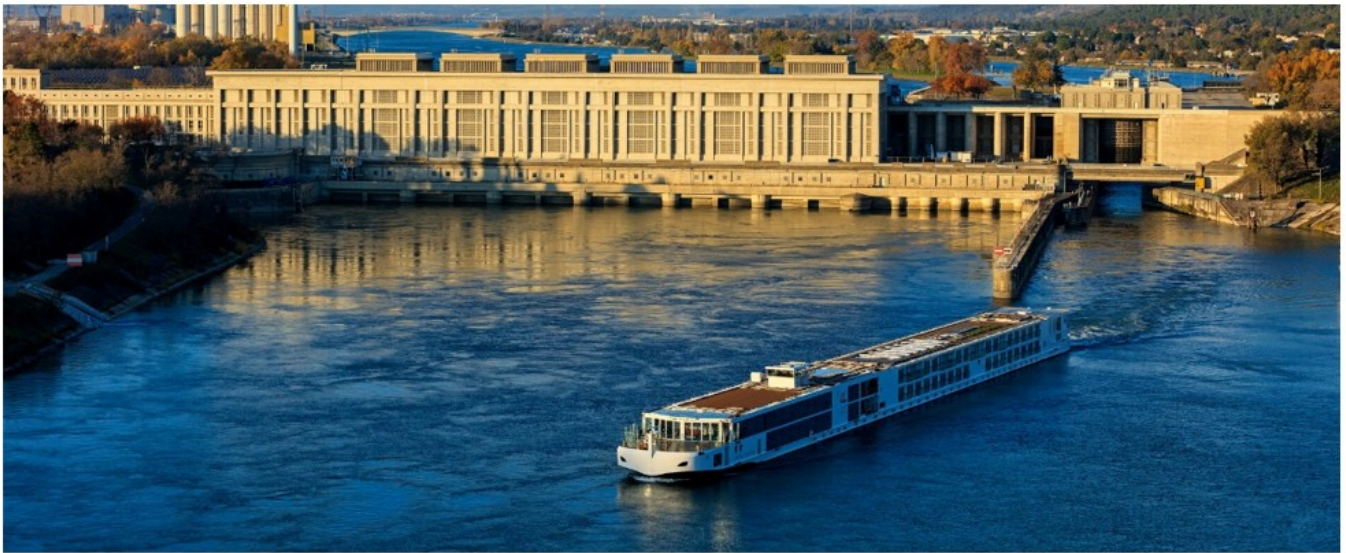
L'écluse de Bollène, qui jouxte l'usine hydroélectrique André Blondel (Vaucluse) - ©Camille Moirenc/CNR
