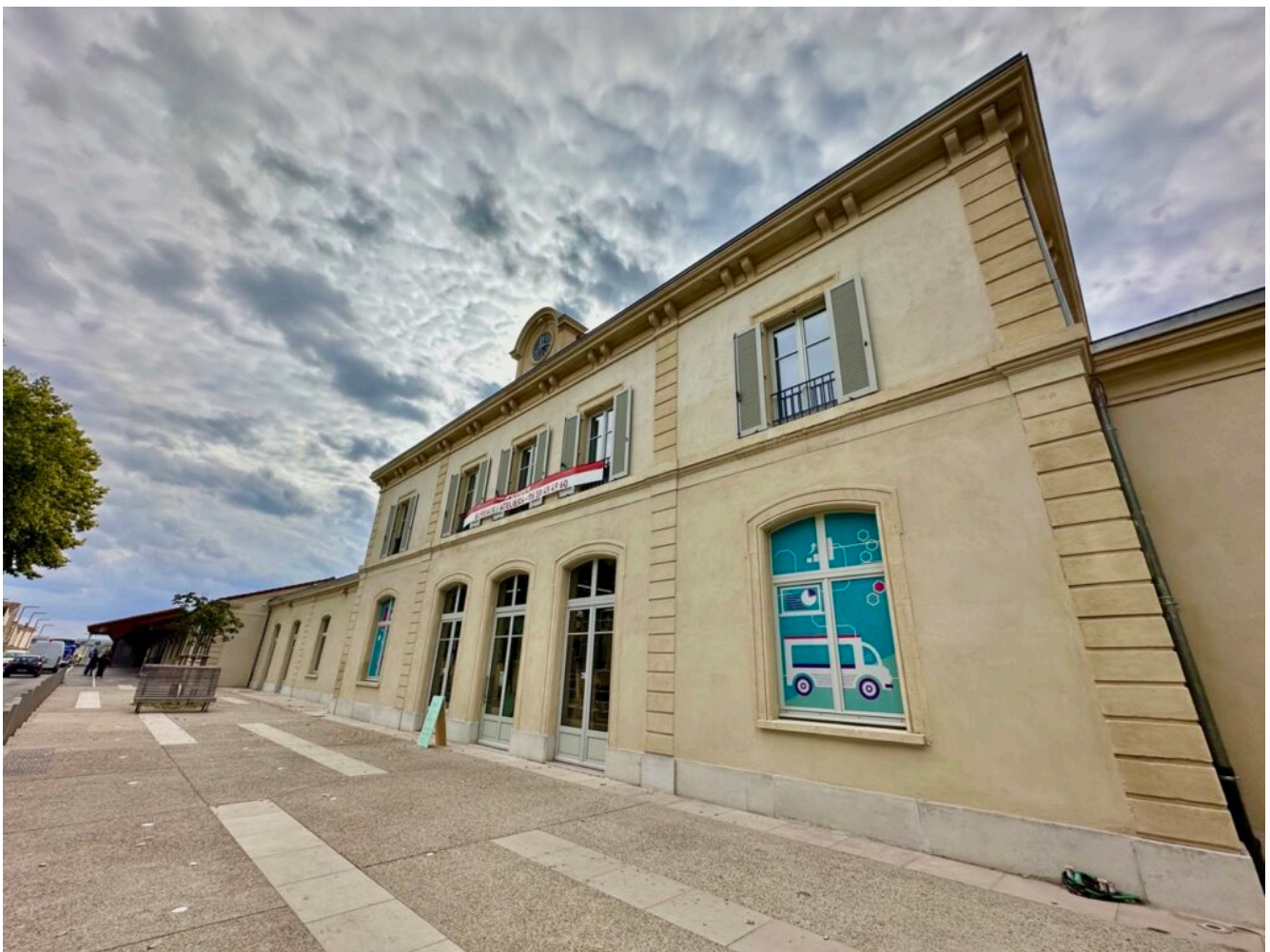
La Gare numérique, vue du côté de l'Avenue de la gare. ©Vanessa Arnal
