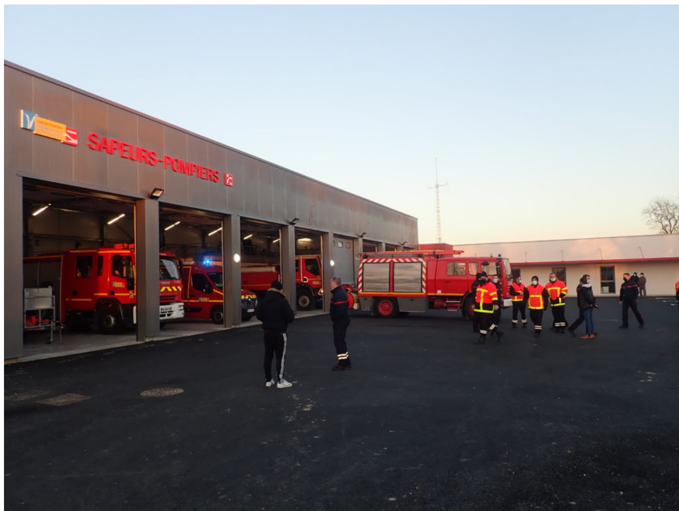
La nouvelle caserne des pompiers se situe à Entraigues. Crédit photo: ville d'Althen-des-Paluds
