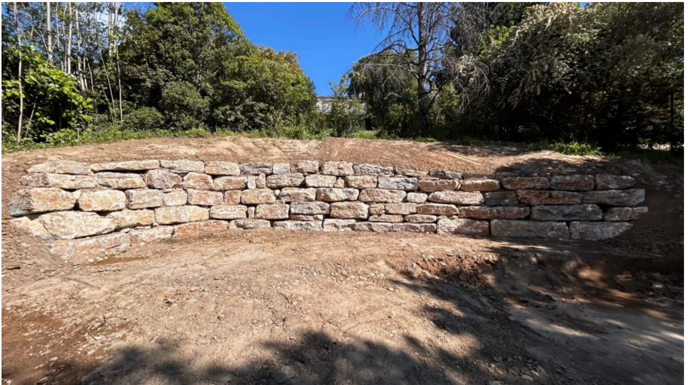
Retenue de terre en pierres Copyright GM terrassement
