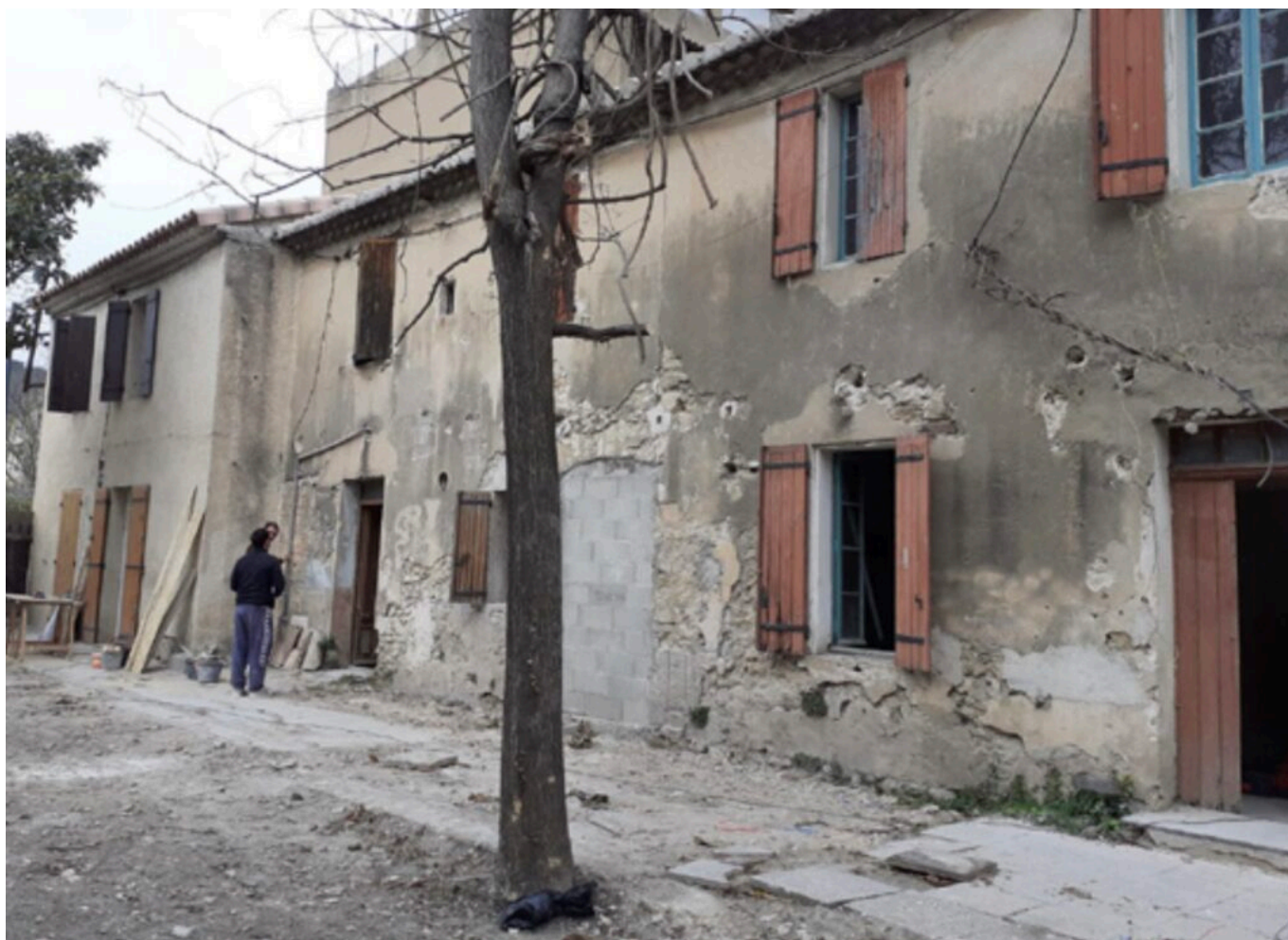
Groupement d'habitations à Châteaurenard avant travaux Copyright Kyaneos
