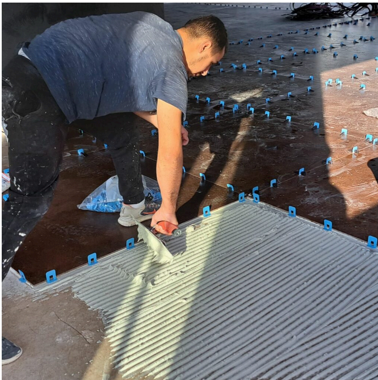
Pose du carrelage ©AB/L'Echo du Mardi
