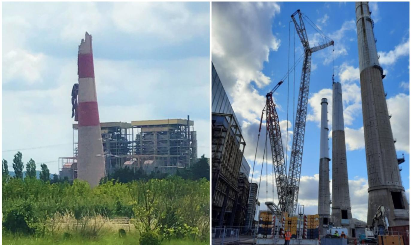
**Après le semi-échec de déconstruction par affalement de la cheminée de l'ancienne centrale thermique d'Aramon, la partie inférieure va finalement être grignotée. L'opération devrait débuter d'ici quelques semaines.**
