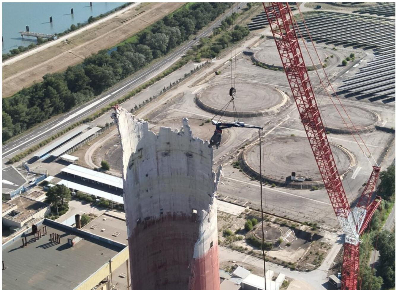
Les travaux sont réalisés par la pince mécanique suspendue à la grue mobile positionnée à côté de la cheminée et alimentée par une pelle hydraulique. L'opération est télécommandée grâce à un système de caméras depuis la cabine de la grue permettant de réaliser l'opération à distance dans des conditions de sécurité.
