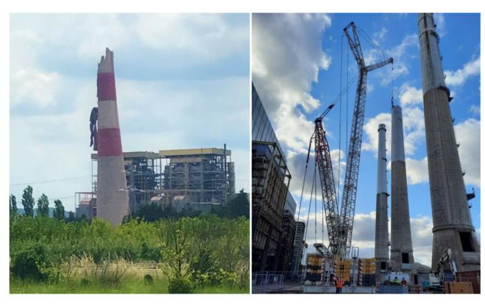
Après le <u>semi-échec de déconstruction</u> par affalement de la cheminée de l'ancienne centrale thermique d'Aramon, la partie inférieure va finalement être grignotée. L'opération devrait débuter d'ici quelques semaines.
