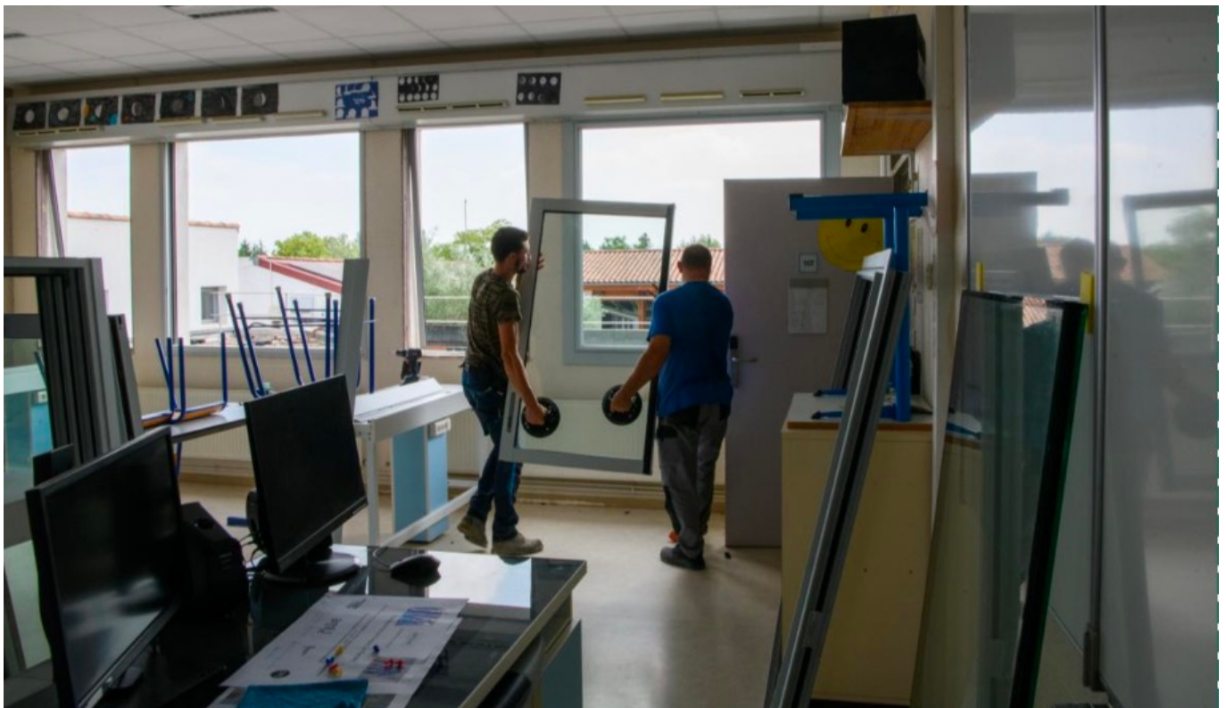
Collège Pays des Sorgues au Thor Copyright Département de Vaucluse
