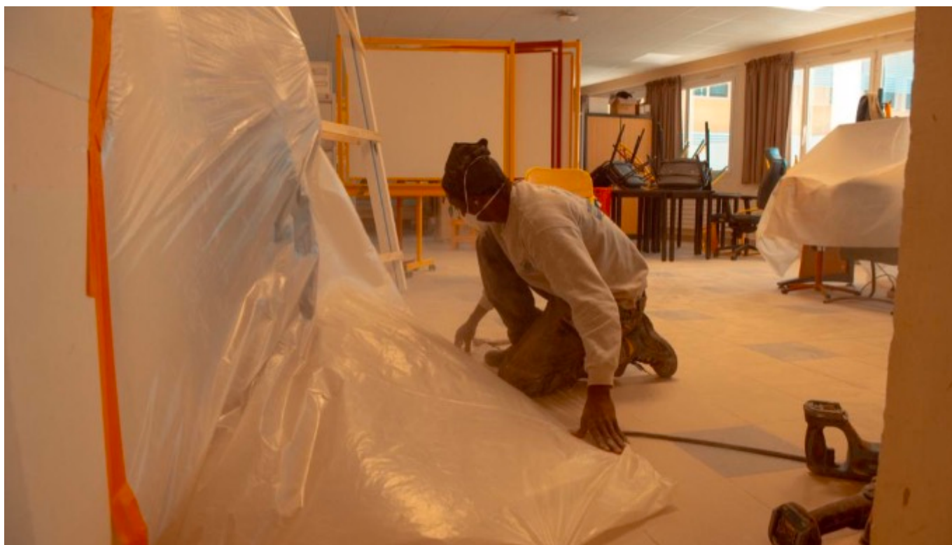
Collège Vallée du Calavon à Carrières d'Avignon Copyright Département de Vaucluse
