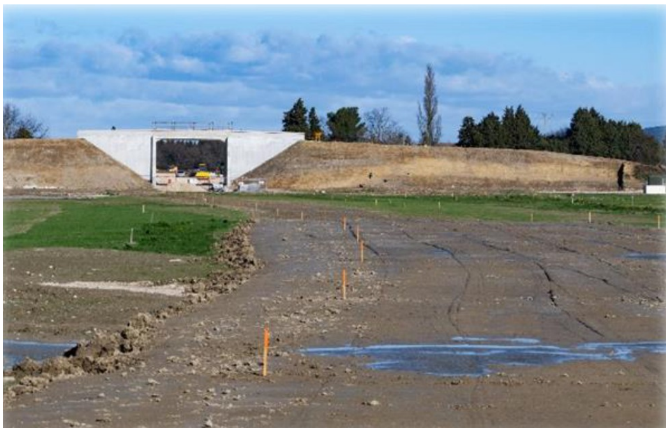
Terrassement du Chemin de Nogaret Copyright Département de Vaucluse
